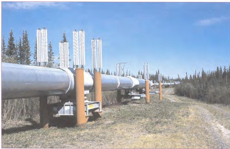
شکل ۹ - استفاده از توربین در پمپاژ خطوط لوله
